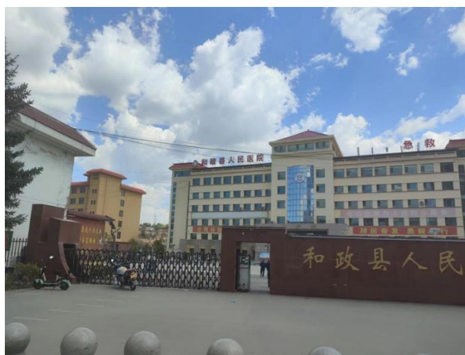
图 1-6 和政县人民医院外景照片
