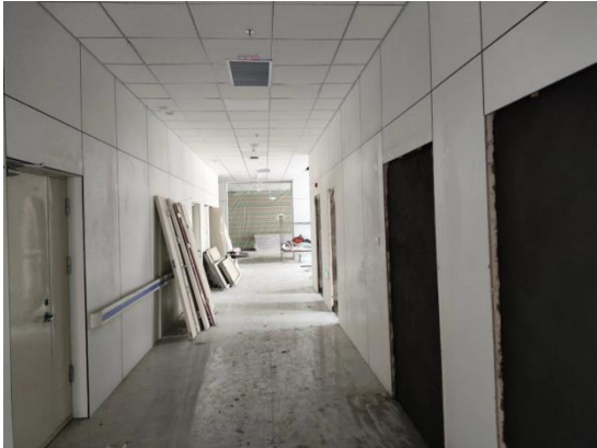
图 8-3 拟建机房北侧通道
