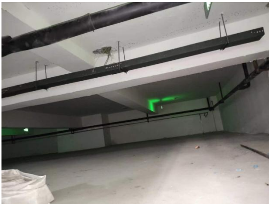
图 8-5 拟建机房楼下管道层
